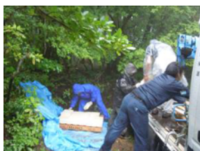
レンガ運びの作業
