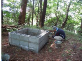
基礎のブロック積み
