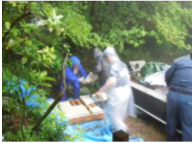
大雨のなか資材を運び込む
