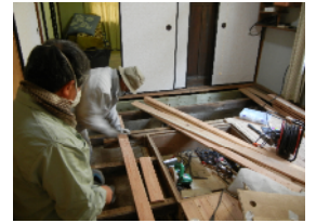
スタッフ室の床補強
