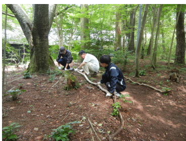
遊歩道の整備
