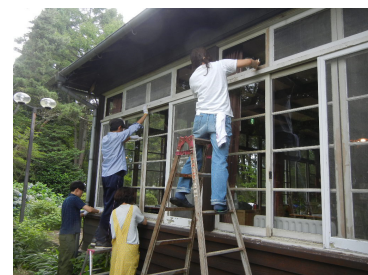
窓枠のペンキはがし
