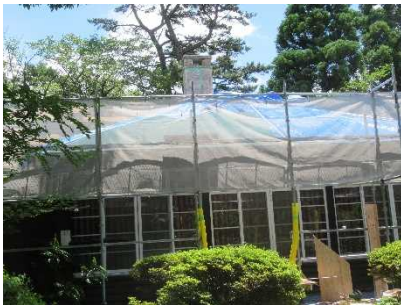
六甲山荘屋根葺き替え工事
