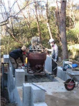
コンクリートの流し込み
