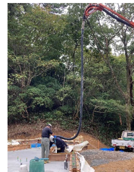
VoriesCottage 基礎工事→ コンクリートを流し込む
