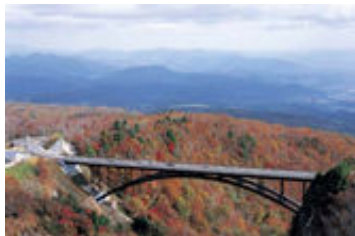
不動沢橋 (磐梯吾妻スカイライン)
